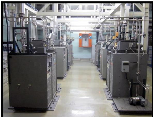
Figure 14 : Dispositifs de contrôle permanent des rejets d'effluents gazeux à la centrale nucléaire de Tihange
