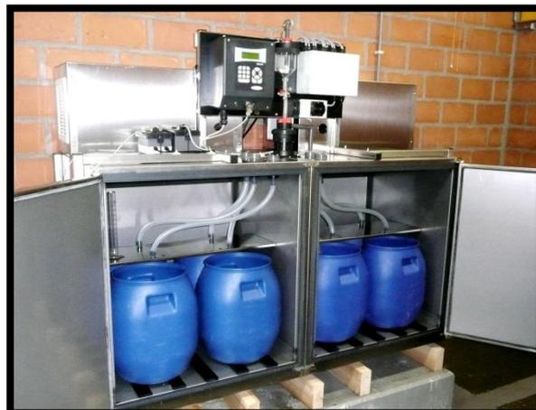
Figure 15 : Dispositif d'échantillonnage automatique des rejets d'effluents liquides à Belgoprocess (site 2)
