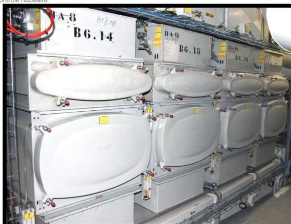
Figure 13 : Caissons de filtration d'aérosols sur un réseau de ventilation de l'IRE, avant rejet à la cheminée
