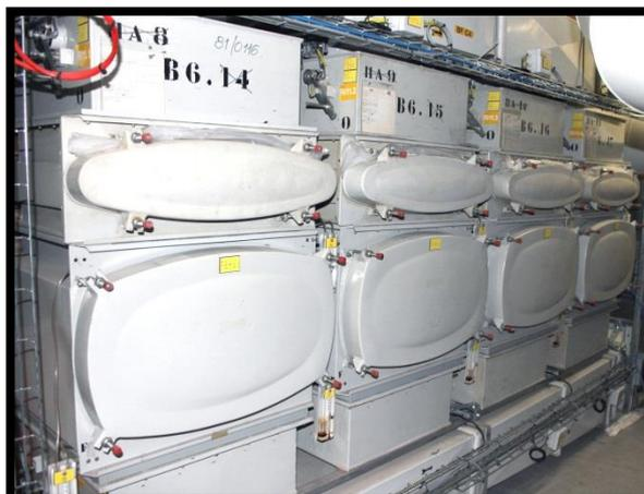
Figure 12 : Caissons de filtration d'aérosols sur un réseau de ventilation de l'IRE, avant rejet à la cheminée
