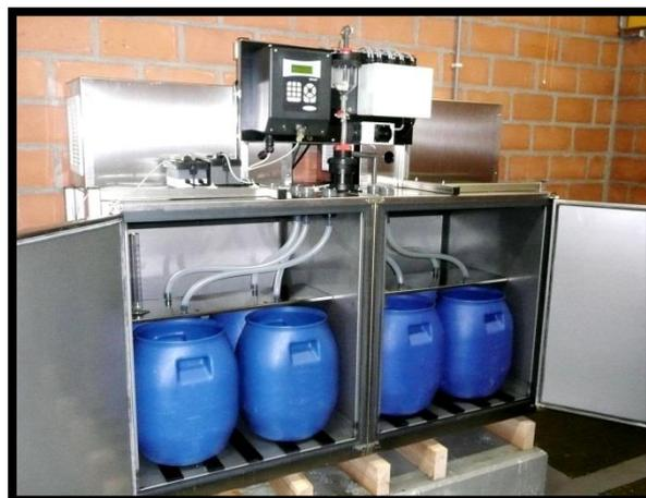
Figure 14 : Dispositif d'échantillonnage automatique des rejets d'effluents liquides à Belgoprocess (site 2)
