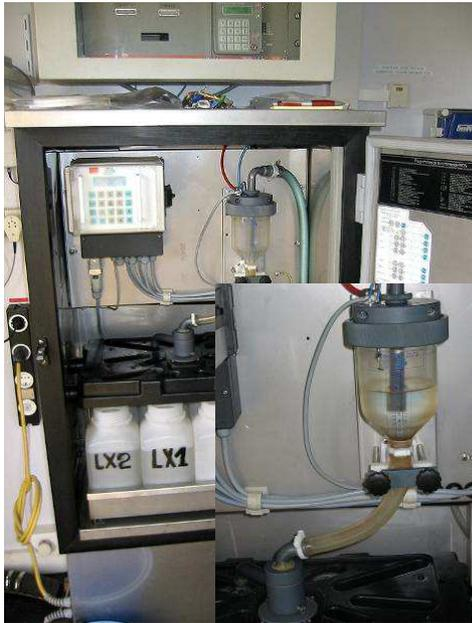
Les eaux sont prélevées automatiquement par les collecteurs indépendants (ppmos) installés dans les containers des balises rivière TELERAD (photos ci-contre à gauche).
